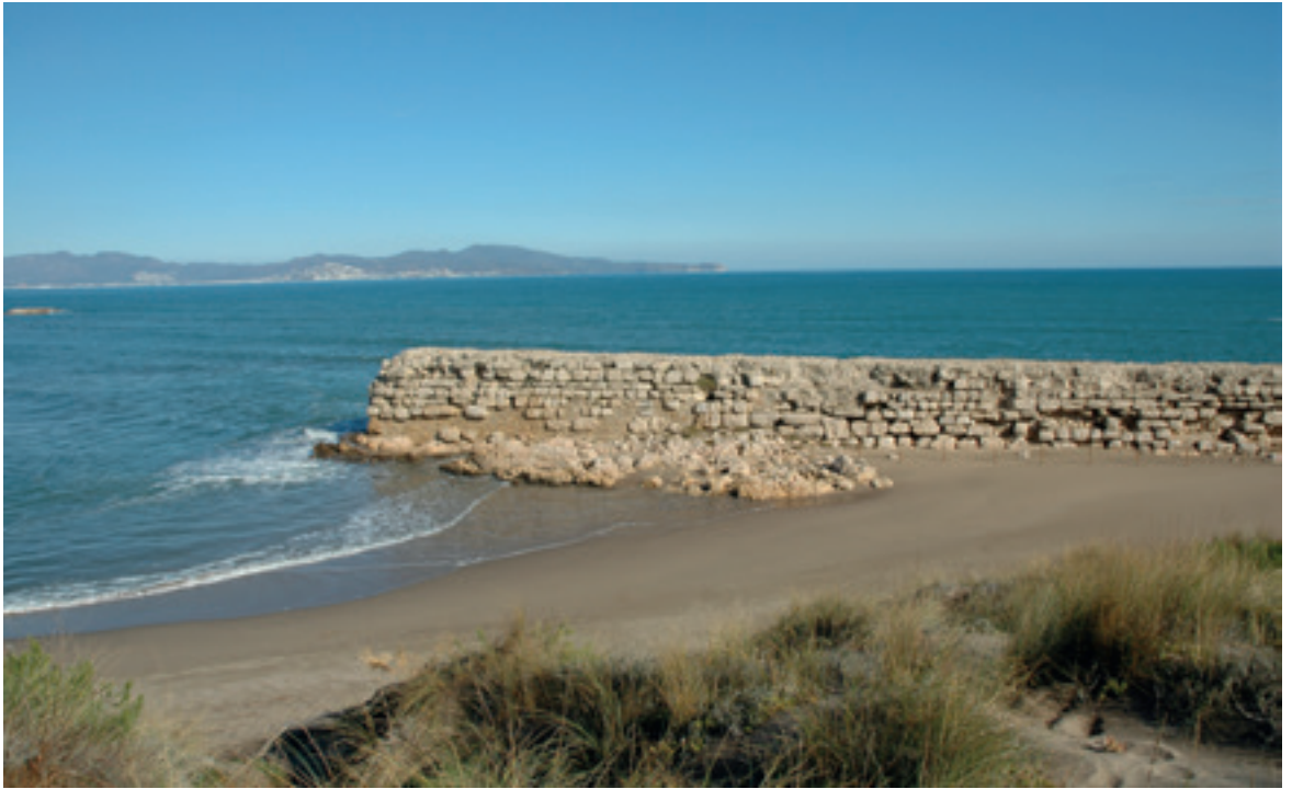
Figura 5. Los restos conservados actualmente del “malecón” emporitano, cimentado sobre la roca y formado por un núcleo de cemento, forrado con grandes bloques de piedra calcárea (Foto: MAC-Empúries).
