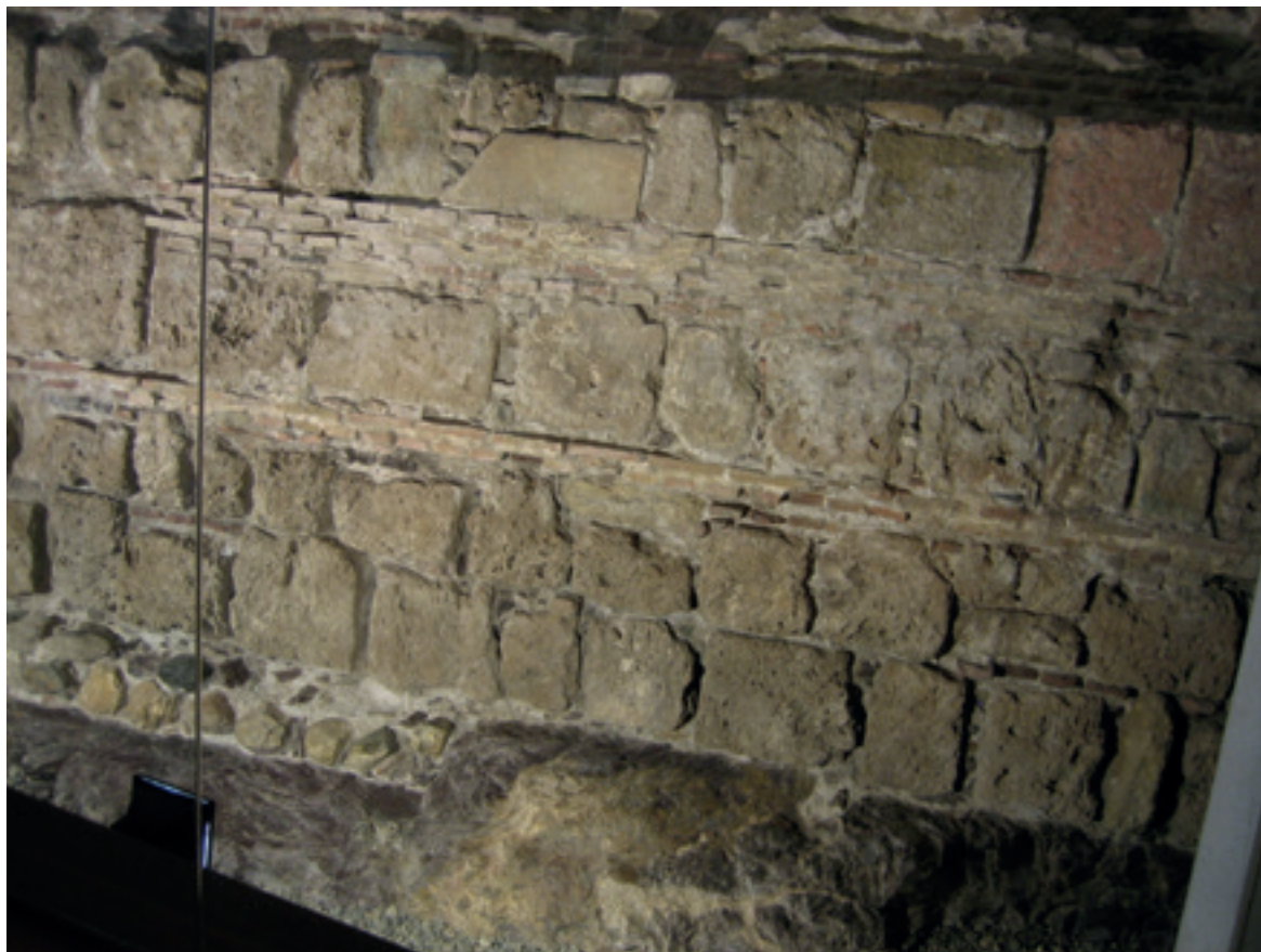
Figura 5. Muro portuario de Málaga, con restos de obra anteriores (B. Mora).
