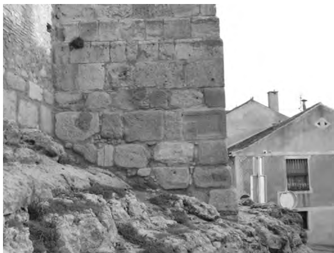
Figura 13. Características constructivas de las partes bajas de las murallas en el sector II. Zócalo de sillería de granito, con abundancia de piezas reutilizadas presentando escalonado a modo de zarpa. Aparejo de sogas organizando hiladas horizontales. Torre T3.
