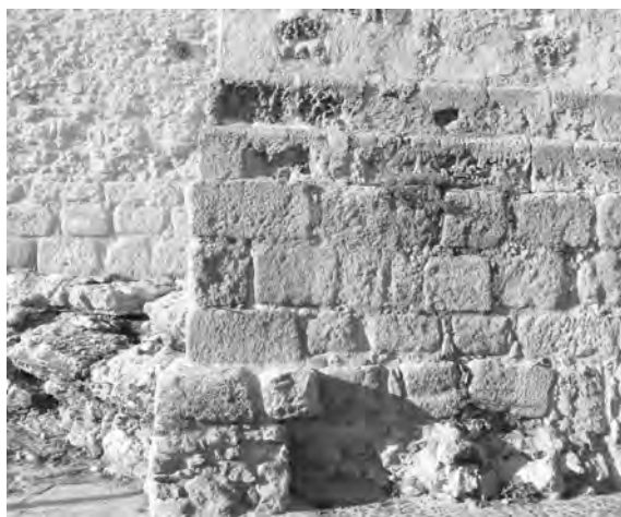
Figura 26. Comparativa de aparejos entre las fábricas de las partes bajas de las torres poligonales y rectangulares. Izquierda: Torre rectangular en sector II.2: Torre 5. El zócalo se realiza sillería de granito aparejada en hiladas horizontales escalonadas a modo de zarpa. El aparejo denota una mayor calidad constructiva que la de las torres poligonales adyacentes. Compárese con la figura 23 y 25.
