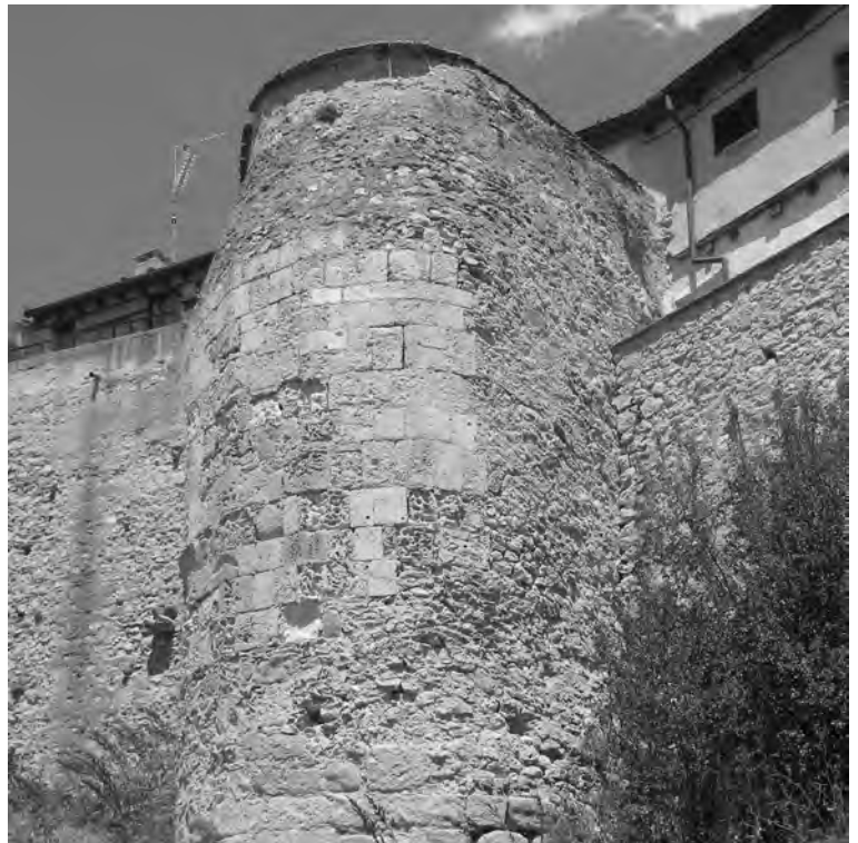
Figura 32. “Aparejo colgado”. Aparejo de sillería conservado en la parte más susceptible de derrumbarse por deslizamiento que se interrumpe de forma extraña hacia su parte inferior y los laterales, las zonas donde lógicamente es más factible su conservación en caso de derrumbe. Esta curiosa disposición hace sospechar que se trata de un chapado parcial. Torre T85. Compárese con la figura 31.
