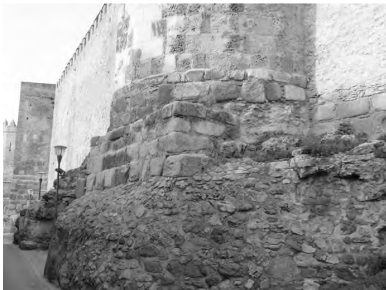
Figura 15. T4: Torre poligonal sobre los restos de una zarpa rectangular. Prueba irrefutable de la anterioridad de las torres rectangulares respecto a las de trazado poligonal.
