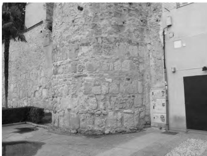
Figura 14. Características constructivas de las partes bajas de las murallas en el sector III. Estas torres presentan el zócalo enterrado, estimamos unos 2 o 3 metros, por lo que desconocemos su composición auténtica. En la parte visible, aparejo de mampostería de piedra sedimentaria muy mezclada, dispuesta a tizón, con hilada horizontal de nivelación. Torre T10.
