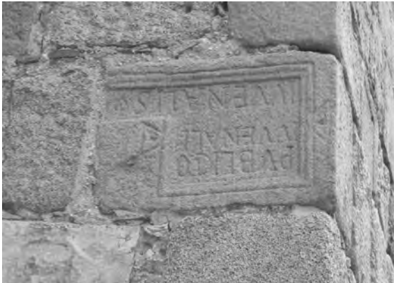
Figura 5. Presencia de piezas reutilizadas en la muralla de Segovia. Izqda: Detalle de la torre T3. Lápida romana. Dcha: Detalle de la torre T2. Otras piezas reutilizadas de difícil datación.
