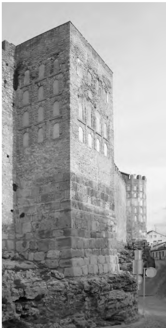
Figura 19. Hipótesis de la construcción de la muralla islámica. Torre rectangular con varias hiladas escalonadas a modo de zarpa de sillería de granito aparejada en la que abundan las piezas reutilizadas. Sobre dicho zócalo se dispone una fábrica igualmente de sillería sedimentaria que en algunos casos llega hasta el adarve. Torre T3.
