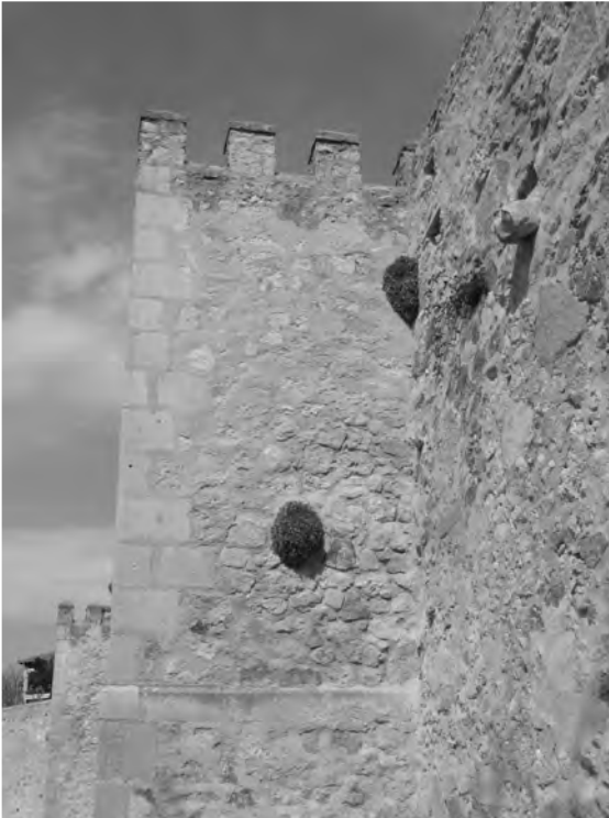
Figura 9. Características constructivas de las partes altas de las murallas en el sector I. Mampostería desconcertada con sillería en las esquinas de las torres. Torre T75.
