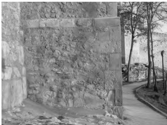
Figura 12. Características constructivas de las partes bajas de las murallas en el sector I. Mampostería desconcertada con sillería de piedra sedimentaria en las esquinas de las torres. A veces éstas presentan zócalo resaltado, pero nunca escalonado. Eventualmente aparece una “hilada” de piezas de granito para evitar el contacto con el terreno, como se observa a la izquierda de la imagen en el lienzo. Torre T75.
