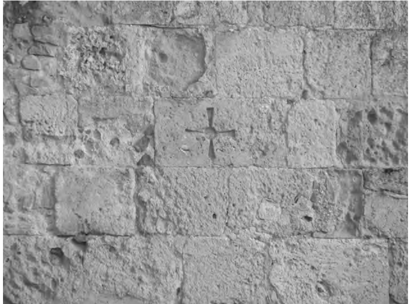
Figura 1. Detalle de la torre T5.7. La buena factura de las piezas de sillería hace pensar que podría tratarse de una fábrica realizada ex-profeso, pero la presencia de piezas claramente reutilizadas se hace patente en el negativo en uno de los sillares de una cruz engastada de enorme parecido con las cruces visigodas y asturianas.
