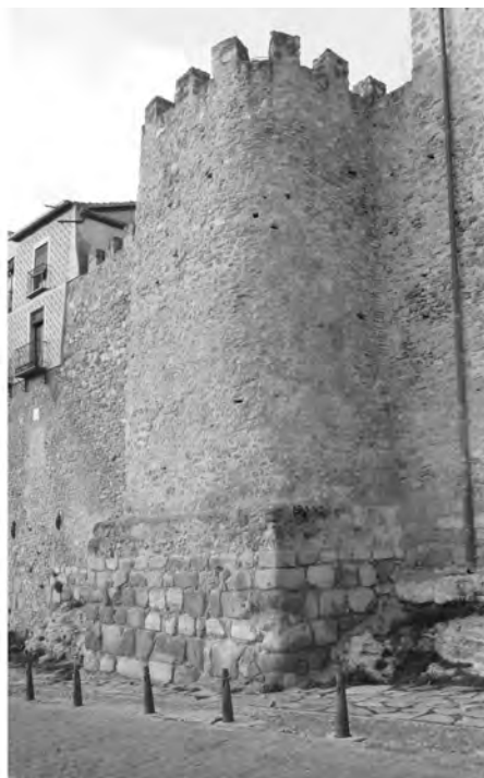
Figura 36. Restos de la muralla musulmana, según nuestra hipótesis, sobre la que se ha levantado la torre en mampostería, redondeando las esquinas. Torre T7.
