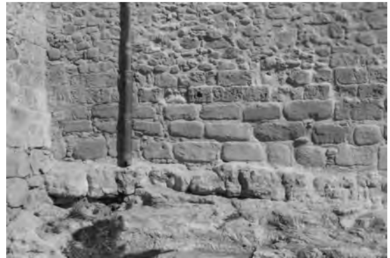
Figura 21. Lienzo L5-6: Hipótesis de la construcción de la muralla islámica. Zócalo de sillería de piedra de granito reutilizada aparejada en hiladas horizontales sobre la que se aprecia una fábrica de sillería en piedra sedimentaria organizada igualmente en hiladas horizontales a soga. En algunos casos podría presentar zarpa escalonada, como en el lienzo L6-7.
