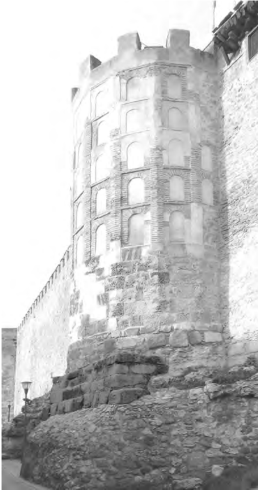
Figura 34. Zarpa de la muralla musulmana de trazado rectangular sobre la que se ha levantado la torre de trazado poligonal en sillería y fábrica de ladrillo. Torre T4.
