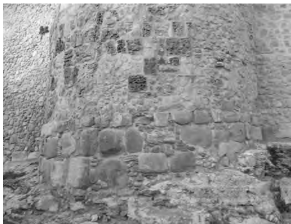
Figura 23. Comparativa de aparejos entre las fábricas de las partes bajas de las torres poligonales y rectangulares. Torre poligonal en sector II.2: Torre T6. El zócalo se realiza en piezas de granito, algunas de ellas sillares, toscamente aparejadas. Se aprecia la mezcla de distintos tipos de piedra. La reutilización de todo el material disponible, incluso piezas de geometría poco regularizada que produce aparejos de baja calidad, en claro contraste con las torres adyacentes. Compárese con la figura 24, 25 y 26.
