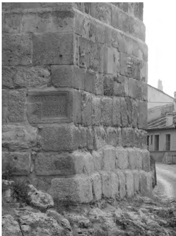
Figura 17. El arranque de la torre en zarpa. Torre T3.
