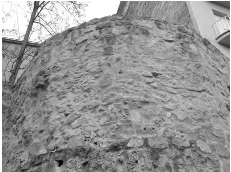
Figura 10. Características constructivas de las partes altas de las murallas en el sector II. Fábrica de ladrillo o mampostería desconcertada. En algunas torres se conserva fábrica de sillería en piedra sedimentaria por debajo de los otros dos tipos de fábricas. Torre T5.
