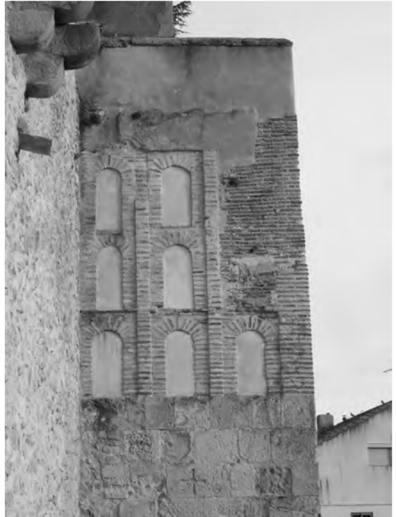
Figura 10. Características constructivas de las partes altas de las murallas en el sector II. Fábrica de ladrillo o mampostería desconcertada. En algunas torres se conserva fábrica de sillería en piedra sedimentaria por debajo de los otros dos tipos de fábricas. Torre T5.
