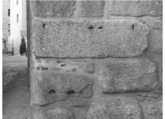
Figura 5. Presencia de piezas reutilizadas en la muralla de Segovia. Izqda: Detalle de la torre T3. Lápida romana. Dcha: Detalle de la torre T2. Otras piezas reutilizadas de difícil datación.
