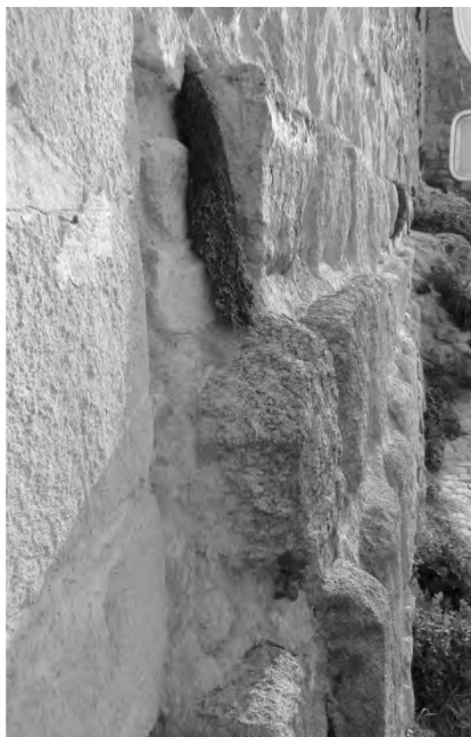
Figura 16. Zarpa en lienzo de muralla. L6-7. Único caso constatado en todo el trazado de la muralla.
