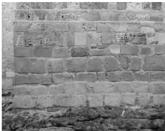
Figura 24. Comparativa de aparejos entre las fábricas de las partes bajas de las torres poligonales y rectangulares. Torre rectangular en sector II.2: Torre 3. El zócalo se realiza sillería de granito aparejada en hiladas horizontales. No hay mezcla de materiales, lo que denota una mayor disponibilidad de granito. El aparejo presenta un orden y regularidad que denota una mayor calidad constructiva que la de las torres poligonales adyacentes. Compárese con la figura 23 y 25.
