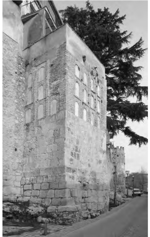
Figura 35. Restos de la muralla musulmana, según nuestra hipótesis, sobre la que se ha levantado la torre en fábrica de ladrillo. Torre T5.
