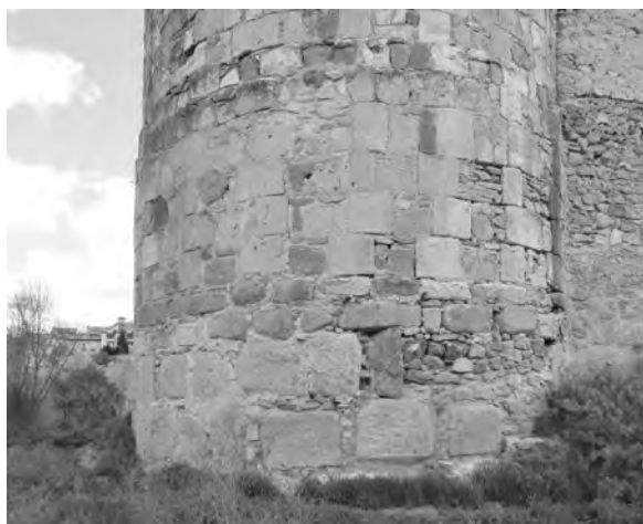
Figura 25. Comparativa de aparejos entre las fábricas de las partes bajas de las torres poligonales y rectangulares. Izquierda: Torre poligonal en sector II.1: Torre T82. Las mismas características que se han indicado en la figura 23, para las torres poligonales del sector II.2. Mezcla de materiales reutilizados y mal aparejados. Compárese con la figura 23, 24 y 26.
